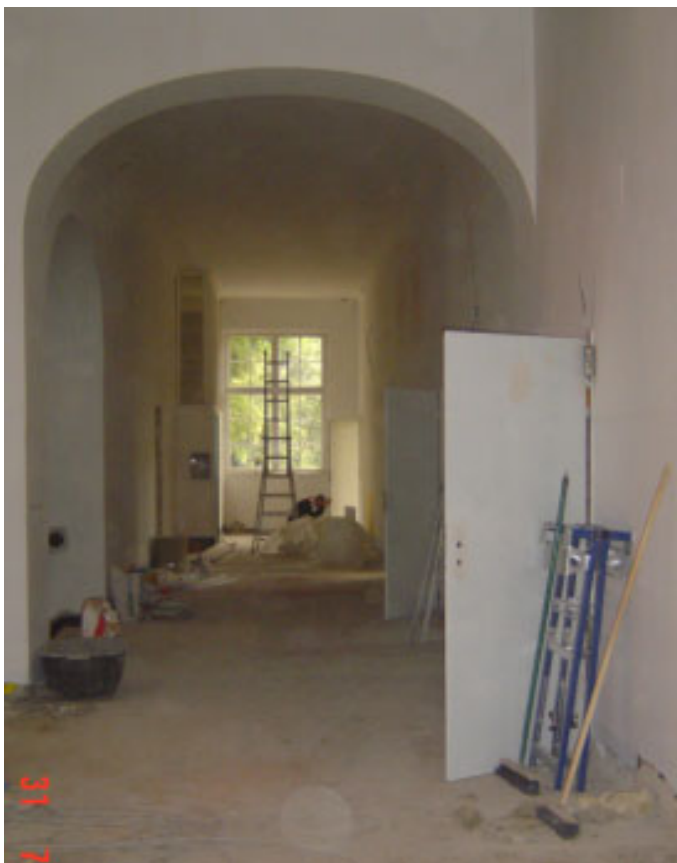
Renovierungsarbeiten in der Evangelischen Schule Berlin-Lichtenberg
