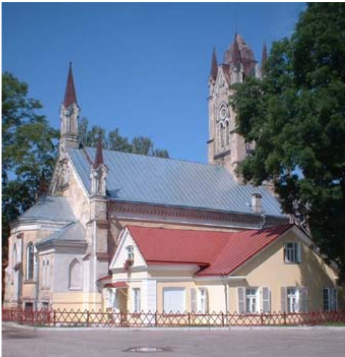
Die Kirche von Grodno ist das einzig erhaltene evangelische Kirchengebäude in ganz Weißrussland, das als Kirche genutzt wird. Das GAW unterstützte die Renovierung.
