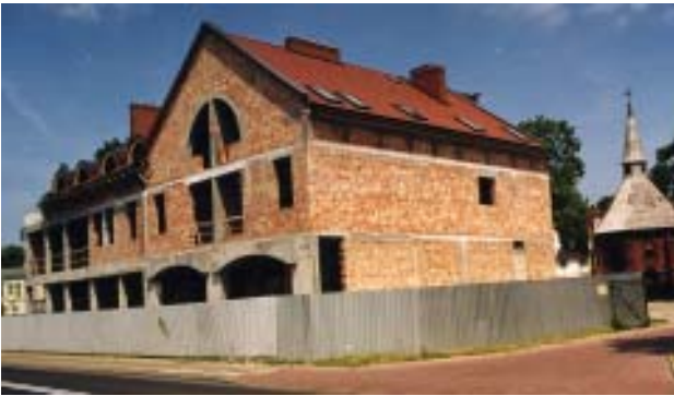
Rohbau Gemeindezentrum und Gertrudenkapelle
