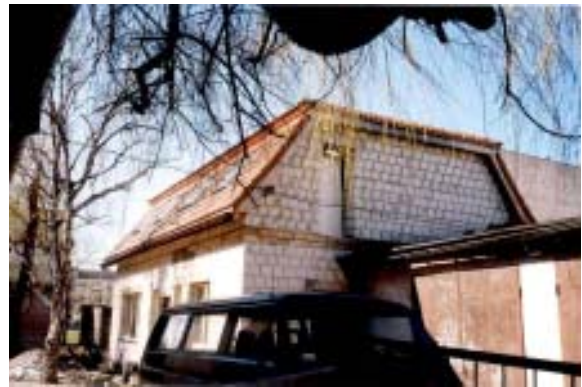
Rohbau des Begegnungszentrums in Pisz, Polen
