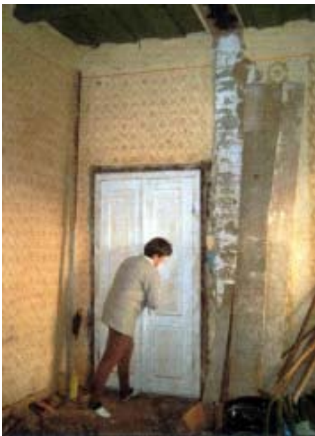
Zustand vor der Renovierung
